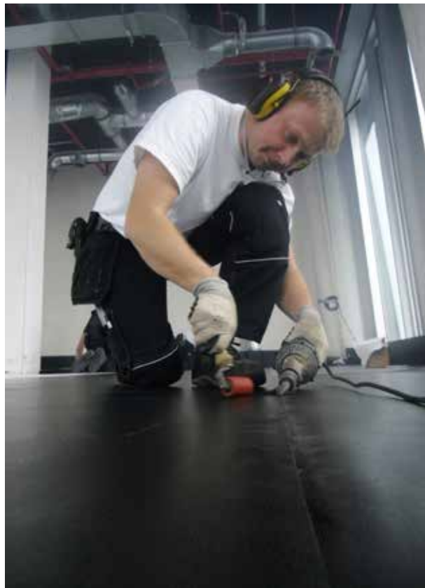
Heiße Arbeit: Verschweißen der Längsnaht
