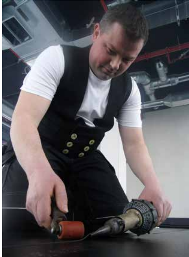
Mitarbeiter der Knitel GmbH & Co KG bei der Verlegung
